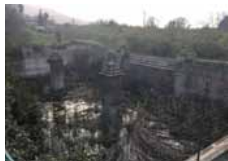
Sant'Agata di Militello: ruins of a furnace in the San Giuseppe district as they appear today (from the outside and from the inside with warping of the masonry wall and some fragments of bricks that remain from the last firing; bottom irrigation tank disused) Sant'Agata di Militello: ruderi come oggi appaiono della fornace in contrada San Giuseppe (dall'esterno, dall'interno, in cui si vede l'orditura della muratura ed alcuni frammenti di mattoni risalenti all'ultima cottura; in basso vasca d'irrigazione in disuso)
