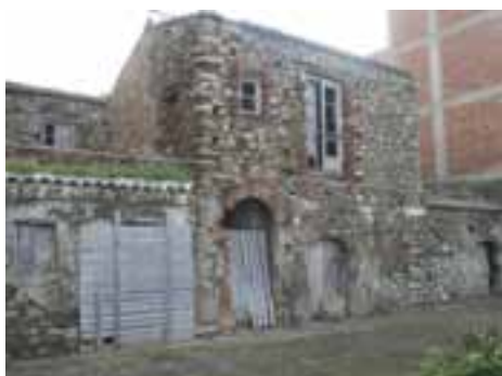
Casa dei Cappuccini: prospetto su via Cosenz House of the Capuchins viewed from via Cosenz
