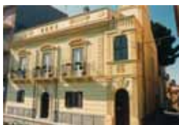
Sant'Agata di Militello: Corrado house before and after the restoration Sant'Agata di Militello: casa Corrado prima e dopo il restauro
