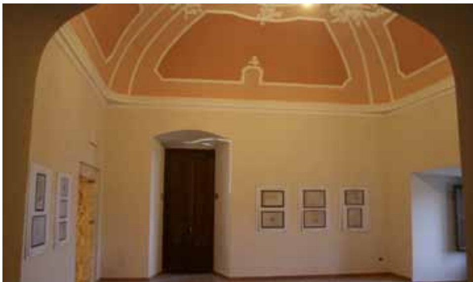
Sant'Agata di Militello: Castello Gallego - interno restaurato con volta decorata Sant'Agata di Militello: Gallego Castle - restoration of the interior with decorated vault
