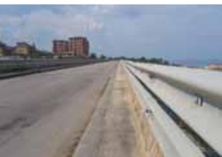
Sant'Agata di Militello: viaduct overlooking the sea Sant'Agata di Militello: viadotto con affaccio sul mare
