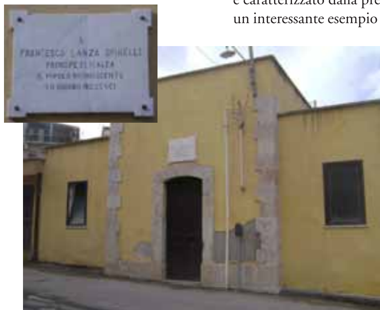
Sant'Agata di Militello: contrada Telegrafo, stabile dove è allocato il serbatoio dell'acquedotto comunale e lapide commemorativa Sant'Agata di Militello: Telegrafo district. A building in which the cistern for the community waterworks is located. There is a small commemorative plaque
