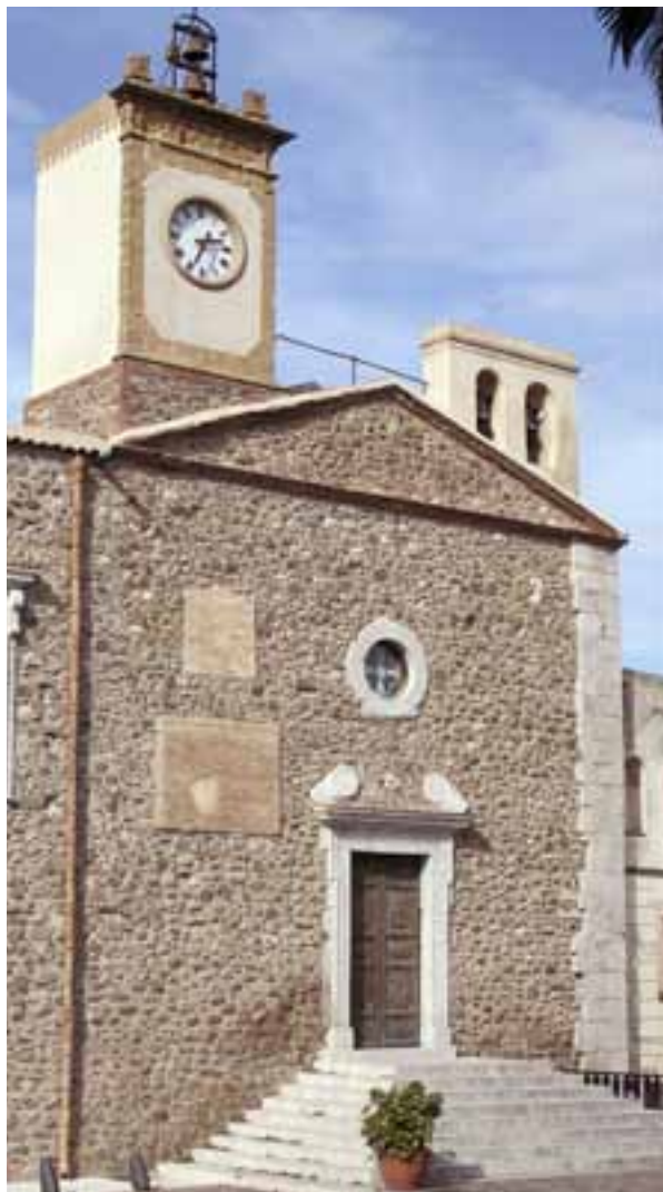
Sant'Agata di Militello: la Chiesa del Castello dopo il restauro Sant'Agata di Militello: Church of the Castle after restoration
