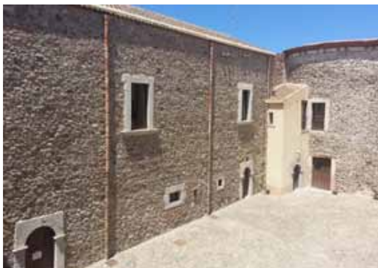
Sant'Agata di Militello: Courtyard of the castle after restoration Sant'Agata di Militello: Corte del castello dopo il restauro
