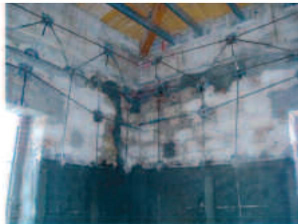
Fig. 8 - CAM: miglioramento sismico di Palazzo Gentile a S. Agata di Militello
