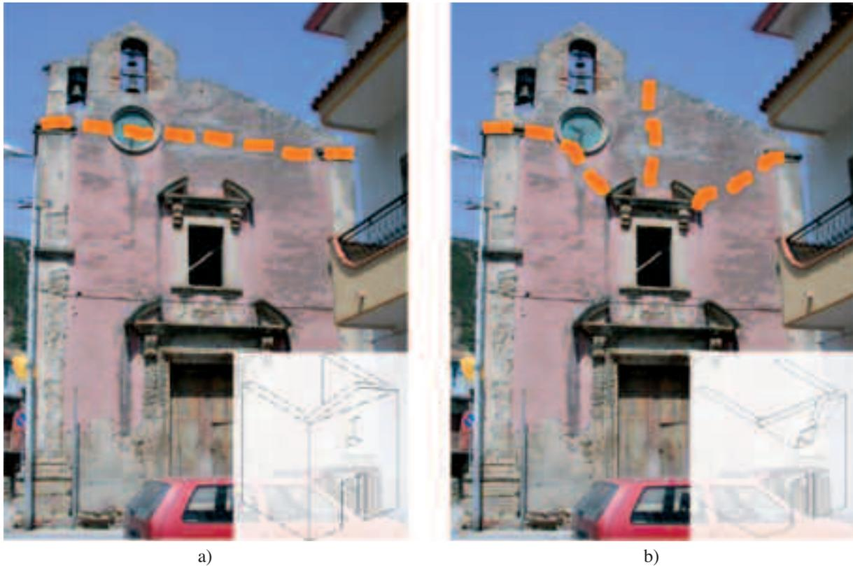
Fig. 5 - Possibili meccanismi fuori dal piano per la facciata della chiesa di San Rocco a Milici
