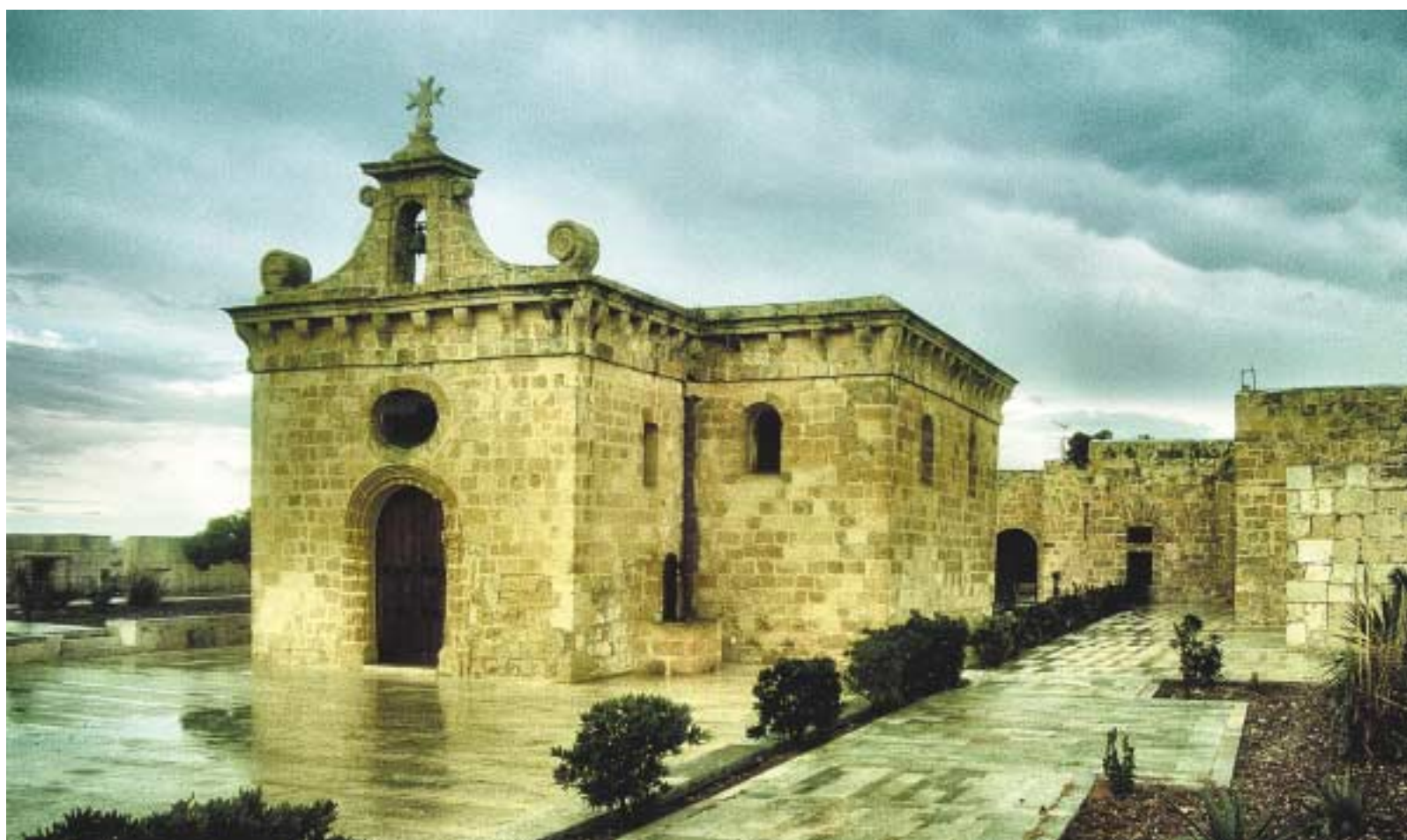
Forte Sant'Angelo, chiesa di Sant'Anna prima del restauro e a lavori ultimati (A.DC.)
