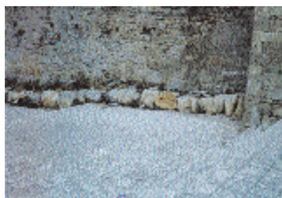
Ibla, resti del muro bizantino vicino alla chiesa del Signore Trovato (C.F., S.LC.,M.M.)
