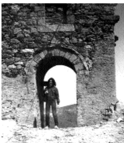
Gagliano Castelferrato Il muro con le cannoniere e la Porta Fauza (E. MSL.)
