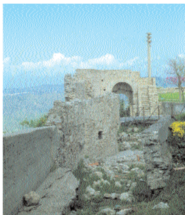
Rometta, fornice interno di Porta Messina (E.MSL)
