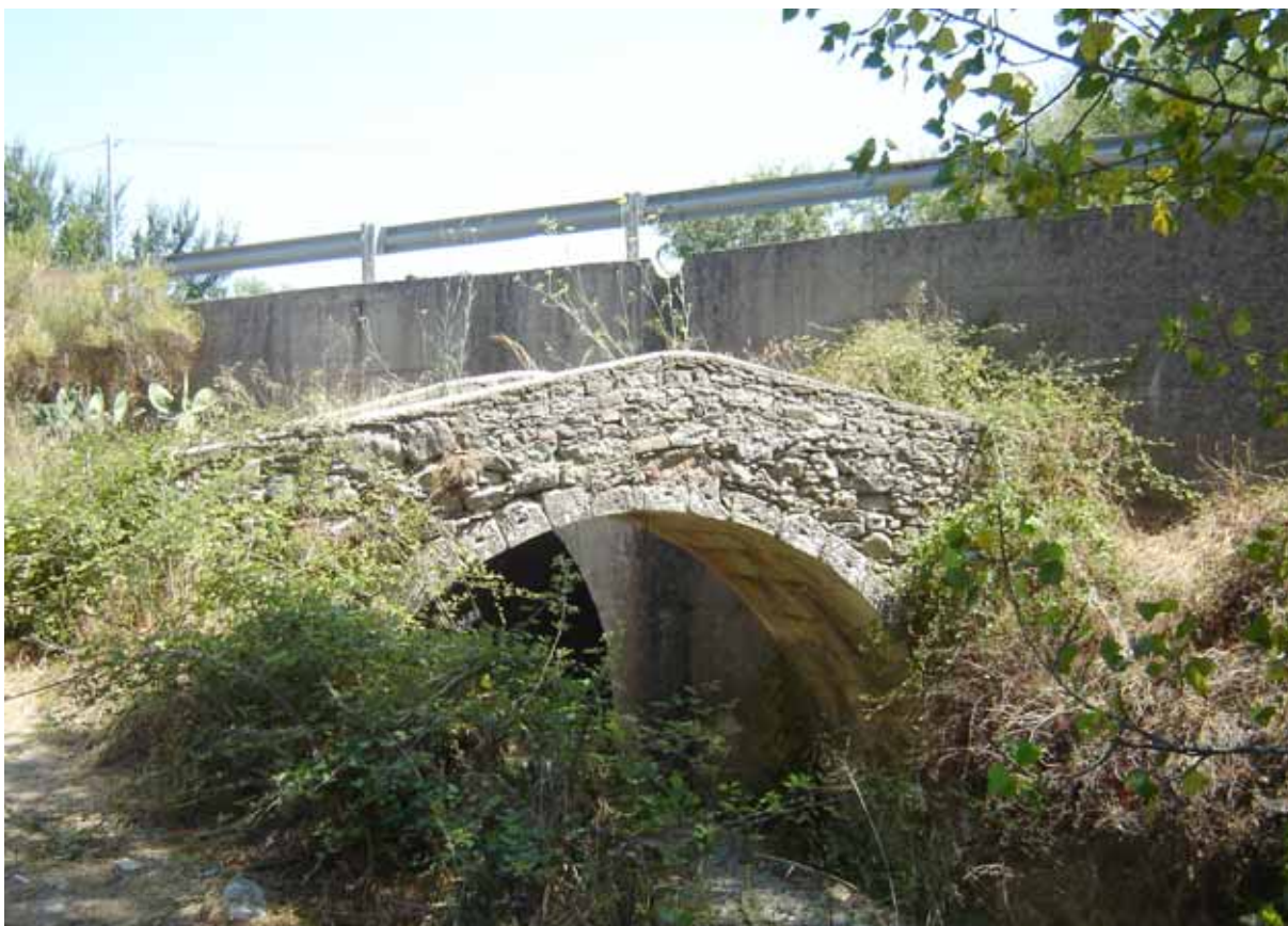
Basicò - L'antico ponte "Prisa" sul torrente Pomarazzo-Fattazza, ormai sottomesso alla nuova strada di recente costruzione.
