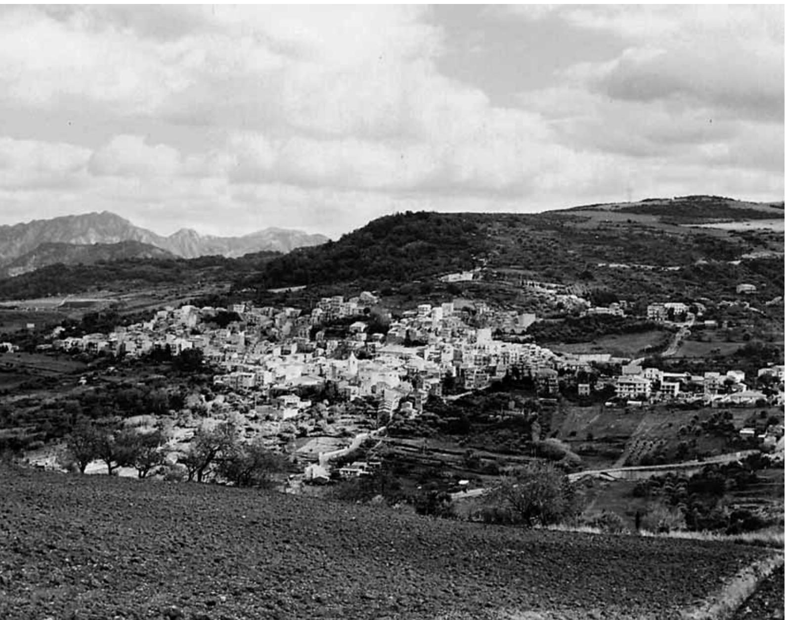
Fig. 3 - Basicò - Veduta panoramica dall'alto, percorrendo la strada provinciale di accesso da nord.
