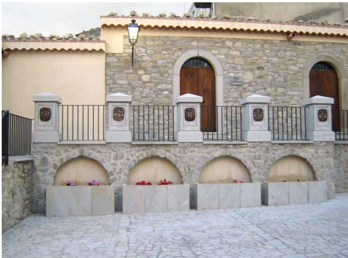
Basicò - Baglio del Castello Baronale, balconata interna con 5 pilastri recanti gli stemmi delle famiglie feudali che governarono Casalnuovo.
