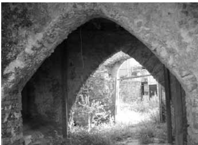
Fig. 17 - Basicò - Palazzo del Governatore, antichi archi sui quali è stata creata la terrazza al tempo della ristrutturazione del palazzo con nuovo piano di calpestio.
