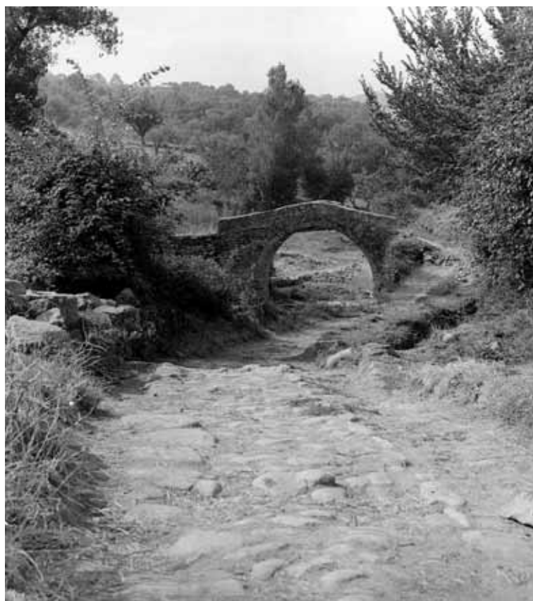
Fig. 7 - Basicò - Foto antica del Ponte «Prisa», in pietra esistente sul torrente Pomarazzo - Fattazza. (Probabilmente Sec. XVIII).
