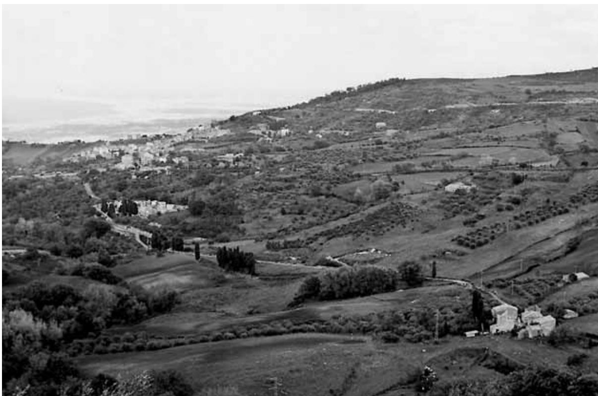
Fig. 43 - Basicò - Foto panoramica di contrada Galice, residenza estiva dei Baroni De Maria (a destra in basso).
