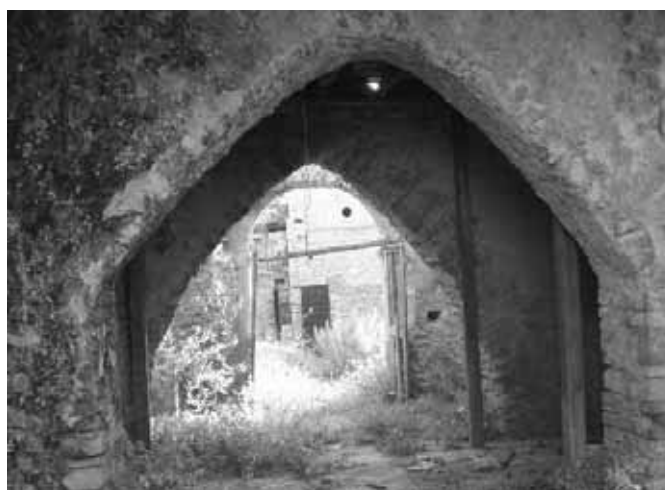
Fig. 18 - Basicò - Palazzo del Governatore, antichi archi su uno dei quali risultano rinforzati gli stipiti.
