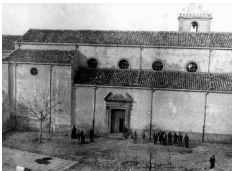
Fig. 28 - Basicò - Chiesa di San Francesco, foto d'epoca, dopo la sistemazione della piazza.
