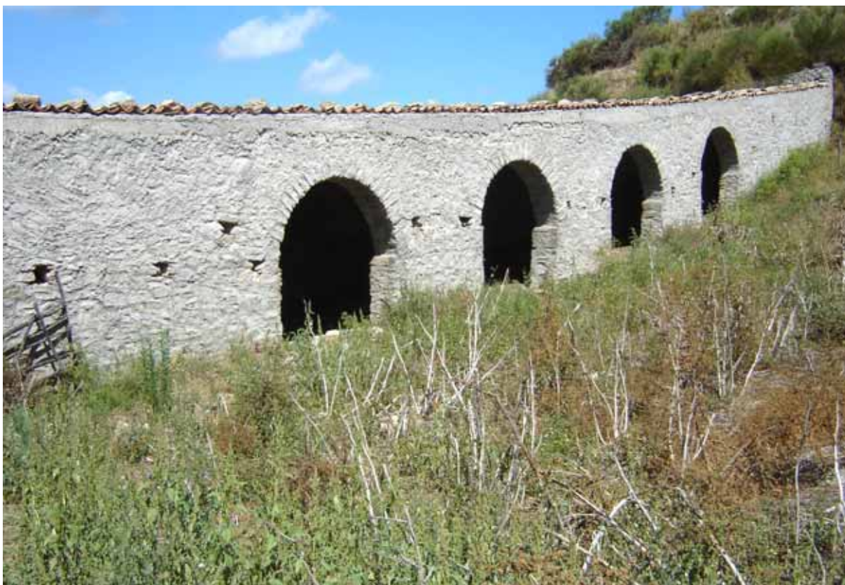
Basicò - Località San Giovanni, archi adiacenti e retrostanti agli antichi fabbricati preposti alle chiuse di San Giovanni.
