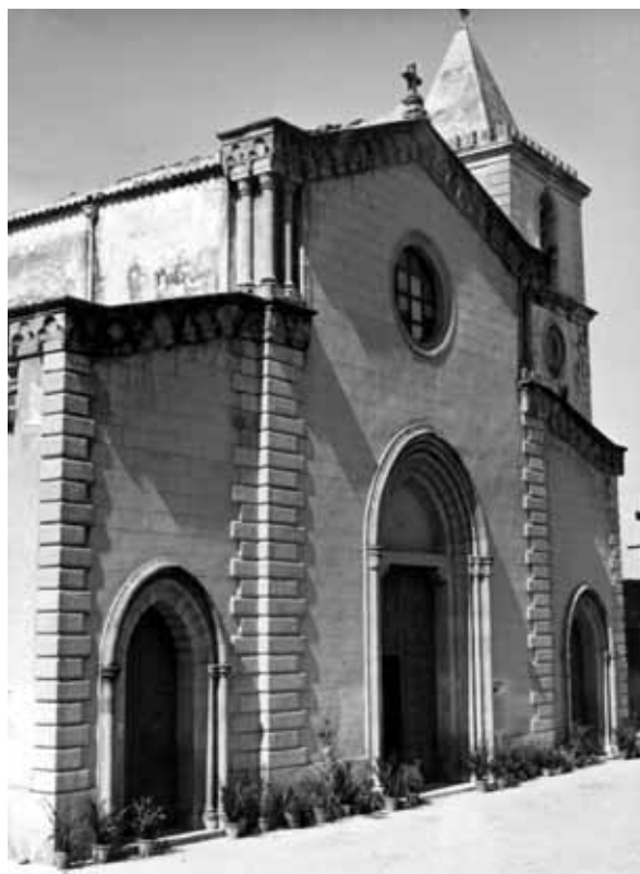
Fig. 30 - Basicò - Chiesa di S. Francesco, facciata e campanile rifatto nel '900.
