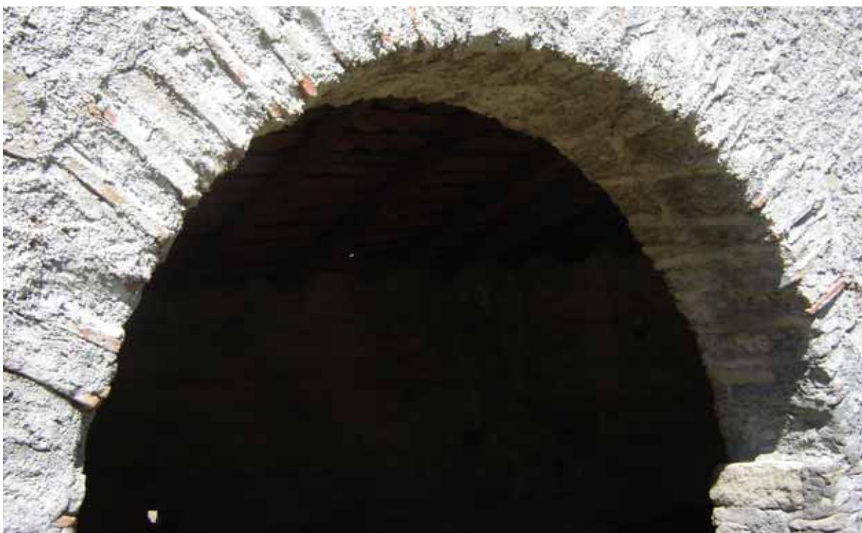
Basicò - Località San Giovanni, uno degli archi retrostanti all'antico fabbricato preposto alle chiuse di San Giovanni. Interessante e da studiare la forma degli stipiti che sembrano rinforzati con murature antiche, forse pilastri portanti antichi archi oggi demoliti. Questi potrebbero far pensare ad una edificazione molto più antica dell'intero complesso oggi visibilmente diverso dopo il recente restauro.
