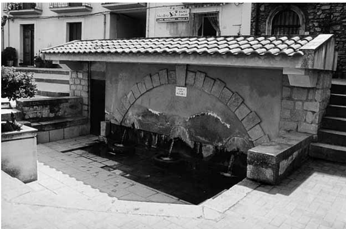
Fig. 9 - Basicò - Piazza L. Foti - «I Tre Carruggi» come si presentano oggi.
