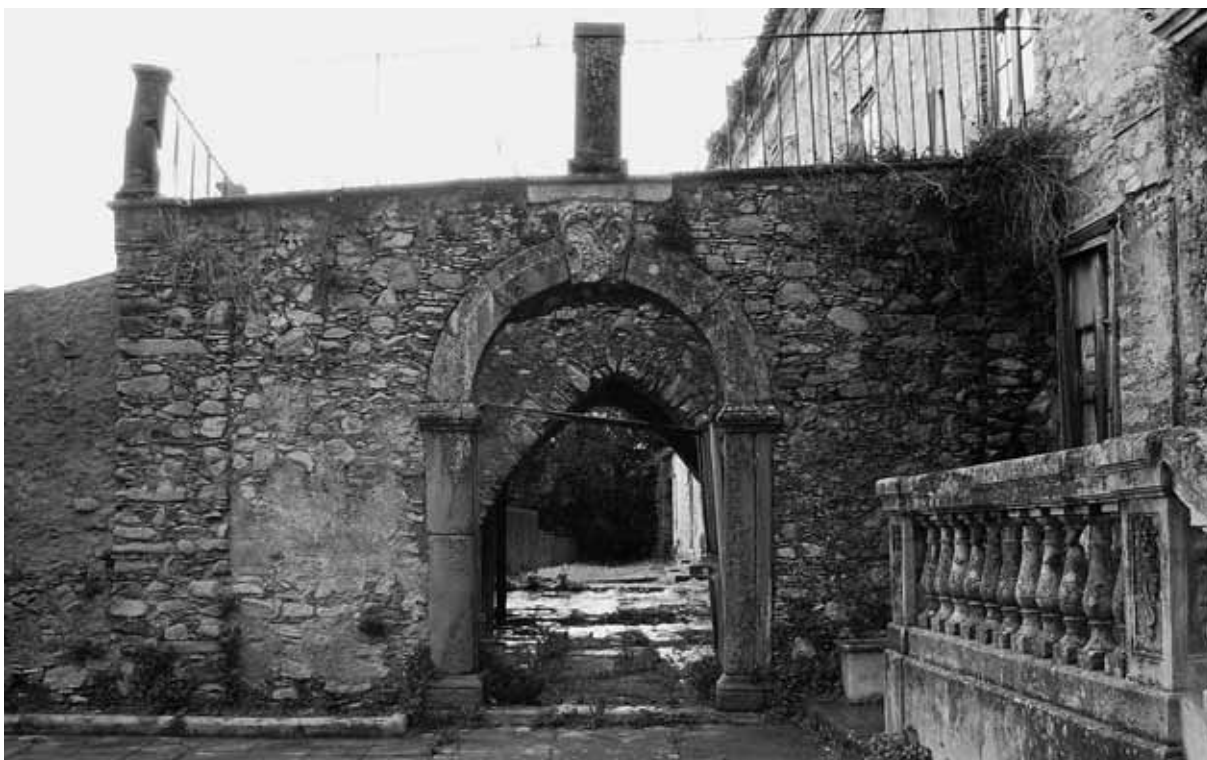
Fig. 16 - Basicò - Palazzo del Governatore, Cortile interno e terrazza.
