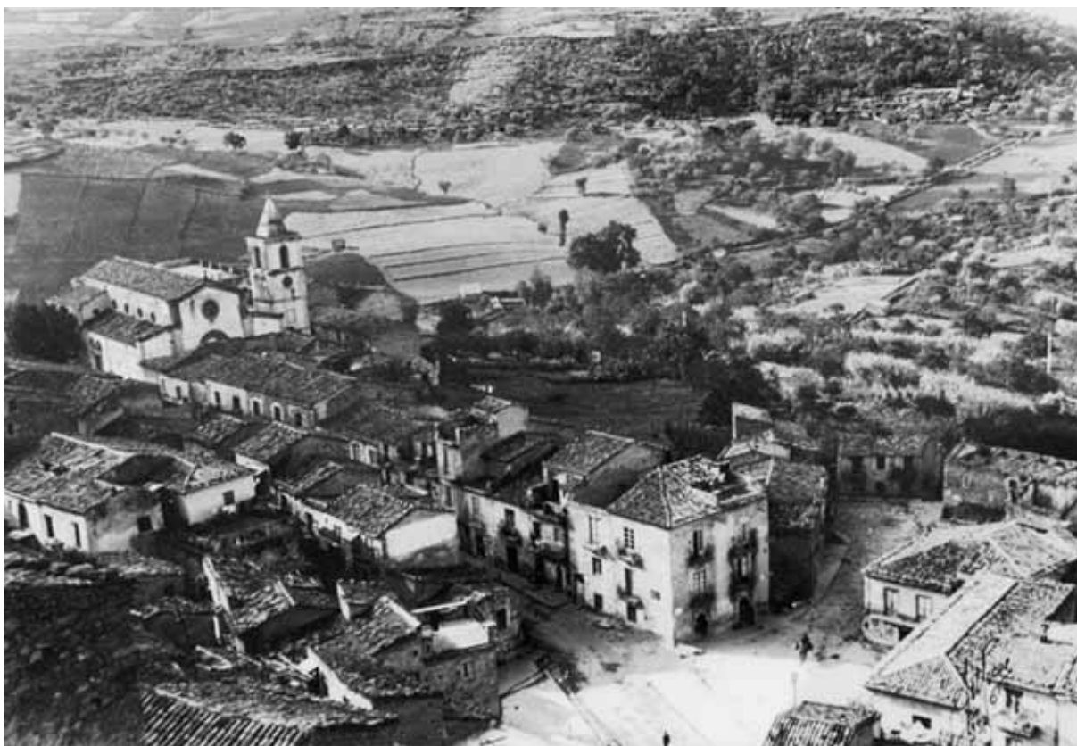
Fig. 22 - Basicò - Panoramica del paese risalente al 1950 (al centro sulla destra la Chiesa di S. Maria, già senza il tetto, ma ancora con le travi in legno visibili).
