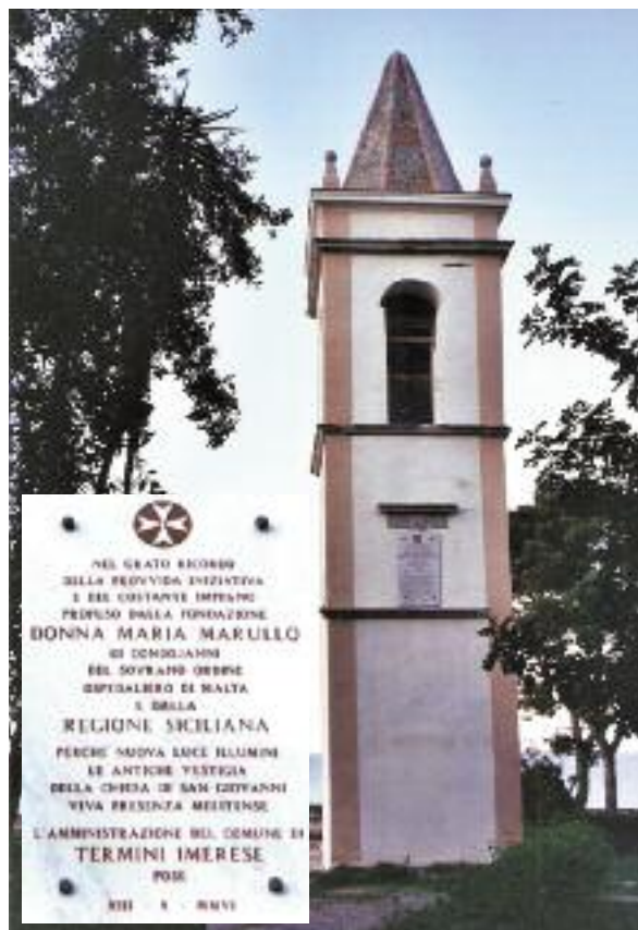
Fig. 1 - Chiesa di San Giovanni in Termini Imerese.
