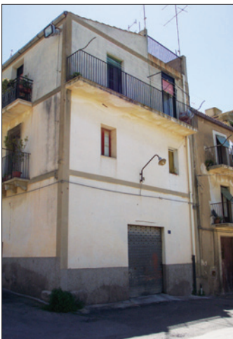
Fig. 108 – Edificio esistente sul sito dell'antica chiesa di S. Giovanni di Malta
