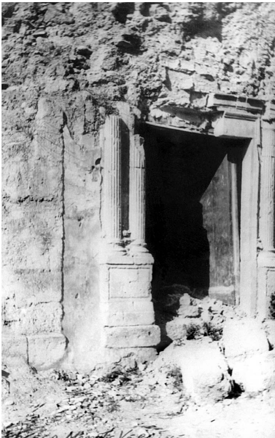
FOTO 5 - La porta del monastero dopo il terremoto
