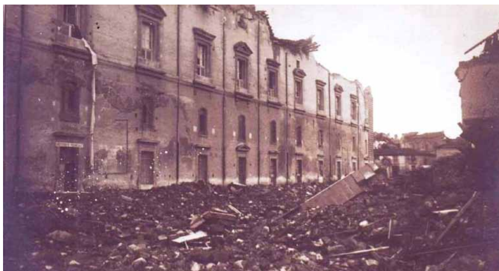
Fig. 5 - Il Grande Ospedale dopo il sisma del 1908. Si notano le lenzuola annodate, utilizzate dai degenti per fuggire dall'edificio
